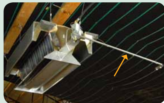
El modelo de baja presión y activación rápida (se muestra con el brazo sensor levantado para izar con malacate).
